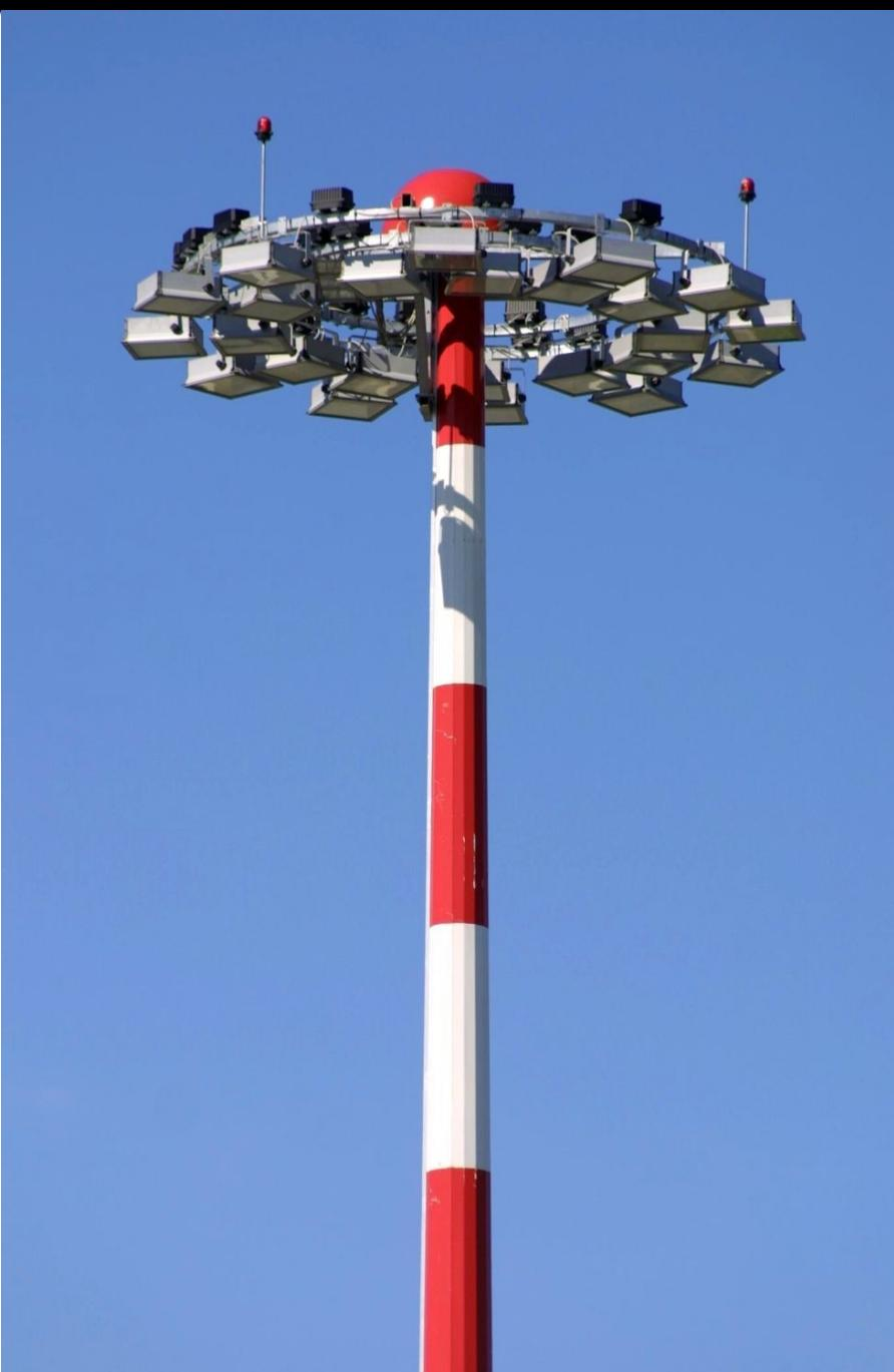
el enrollado del cable. El engranaje es accionado por un motor móvil que puede ser utilizado para varios mástiles. El motor móvil es alimentado por la misma línea de alimentación eléctrica de los proyectores. Todos los controles son de bajo voltaje 24v.
