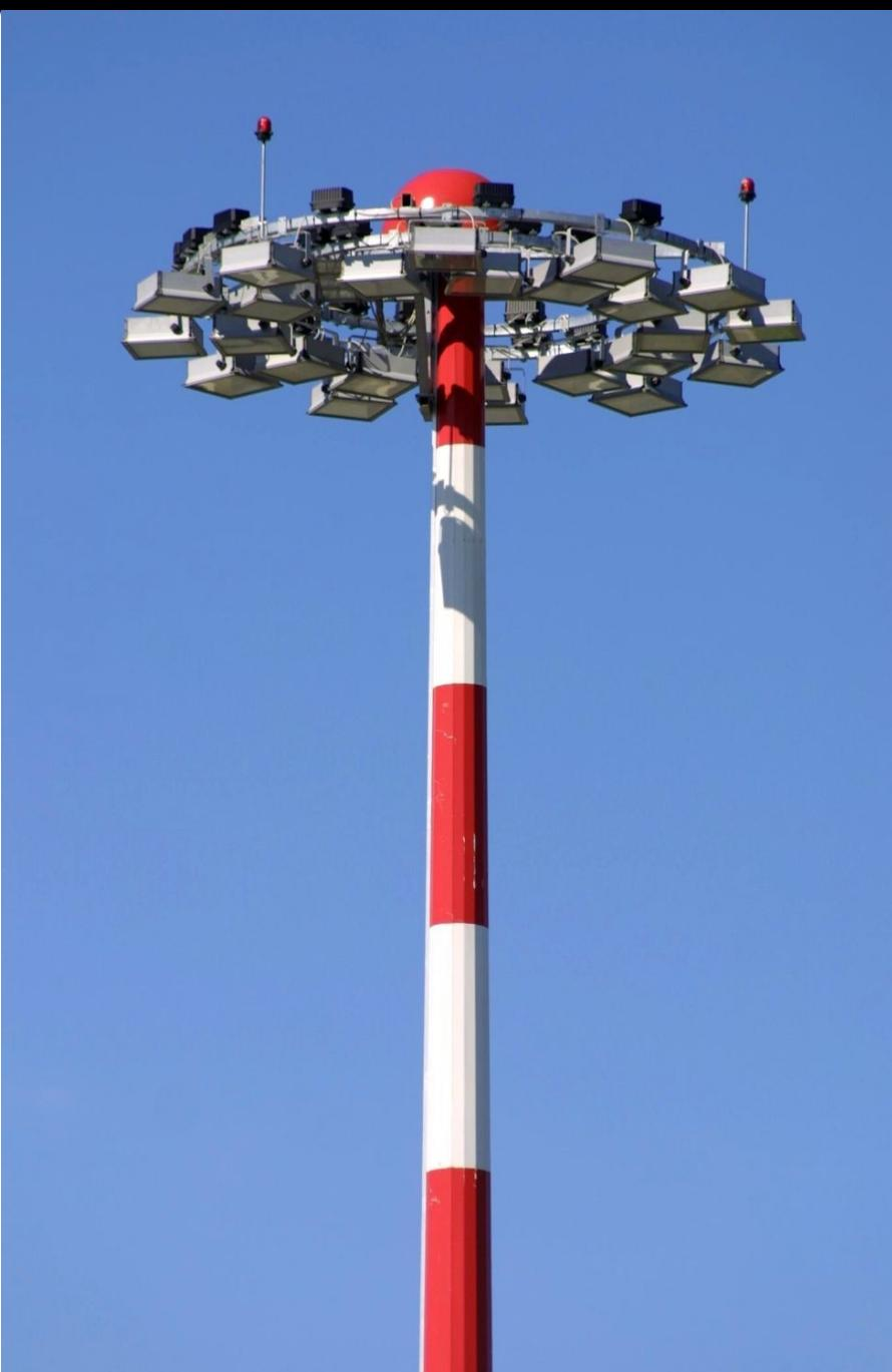
plegada a presión y soldada longitudinalmente. Se deja espacio en la sección de la base para el cabrestante y para el cableado y la apertura eléctrica.
